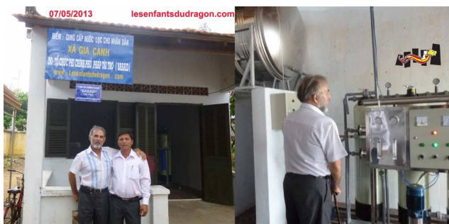
3 ème Station de traitement d'eau potable pour une école de 600 enfants.
