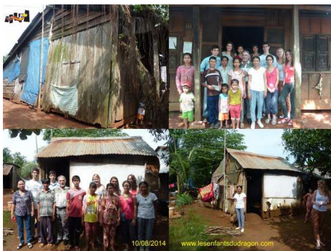
Remise officielle des 2 maisons de charité – Chantier des "Compagnons de Jarny"
